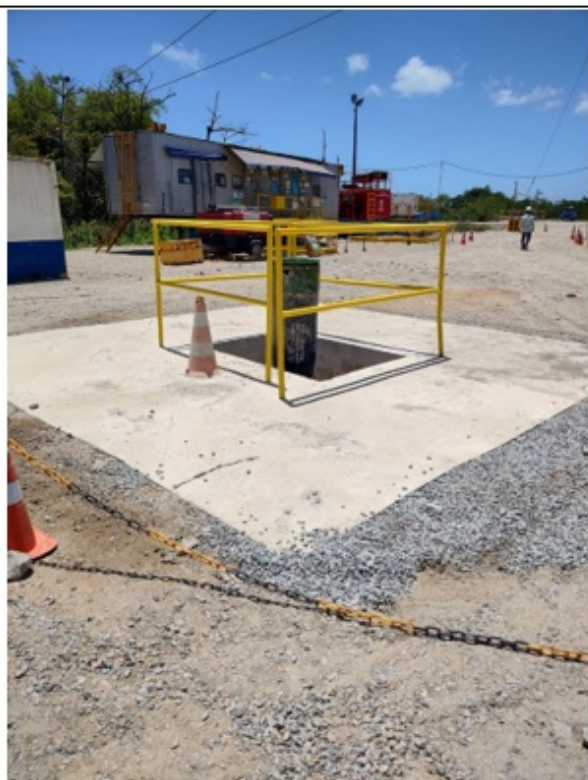
Foto 4 – Estrutura (fundação) de concreto para apoio da sapata, evitando recalques do terreno e inclinações da sonda.
