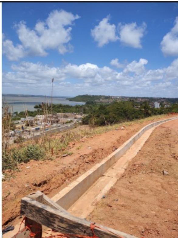
Foto 1 – Continuidade das obras de estabilização do talude da encosta do Mutange : sistema de calhas longitudinais (drenagem).
