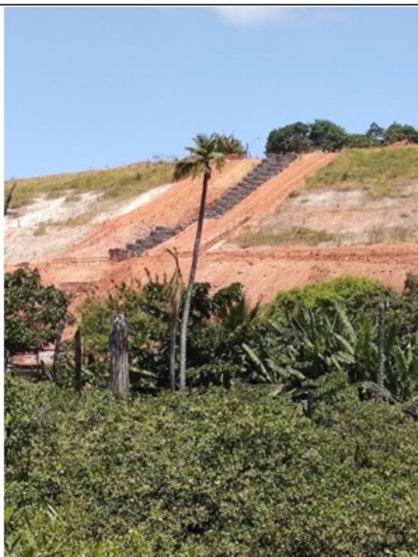
Foto 3 – Continuidade das obras de estabilização do talude da encosta do Mutange : Colocação de gabiões para o sistema de drenagem transversal.
