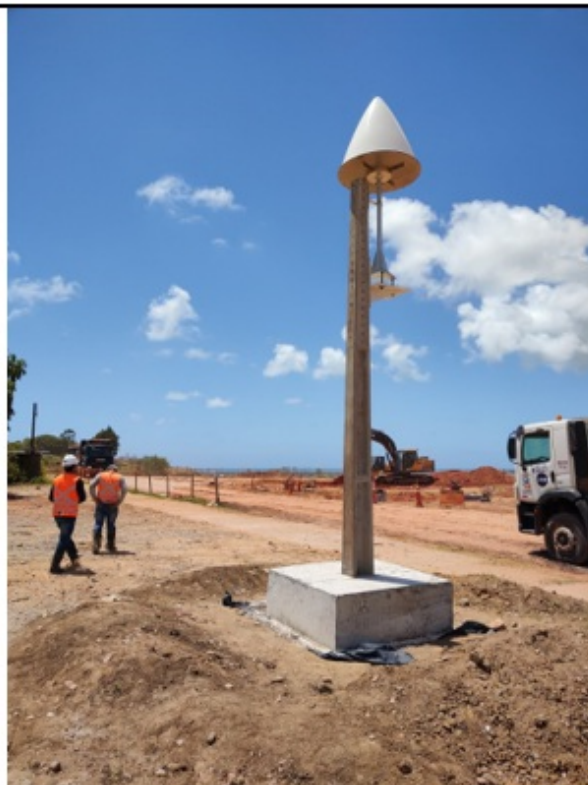
Foto 2 – Instalação de refletores de sinal de satélite para a continuidade da coleta de dados de interferometria.
